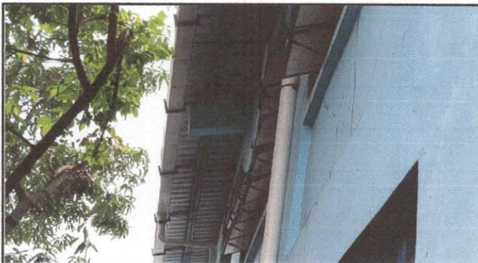
Foto 3: Sustitución de canal PVC
