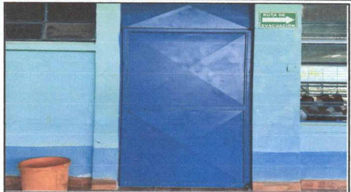
Foto 2: Mantenimiento a estructura
