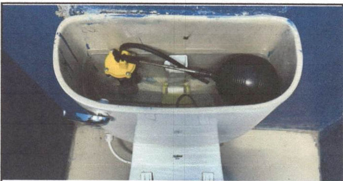
Foto 5: Sustitución de accesorios inodoro
