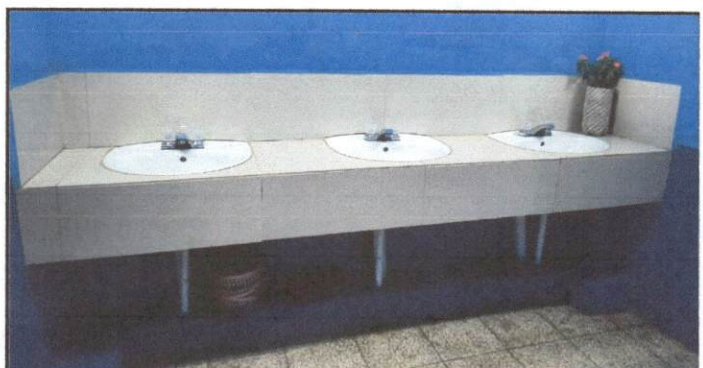
Foto 6: Sustitución de lavamanos
